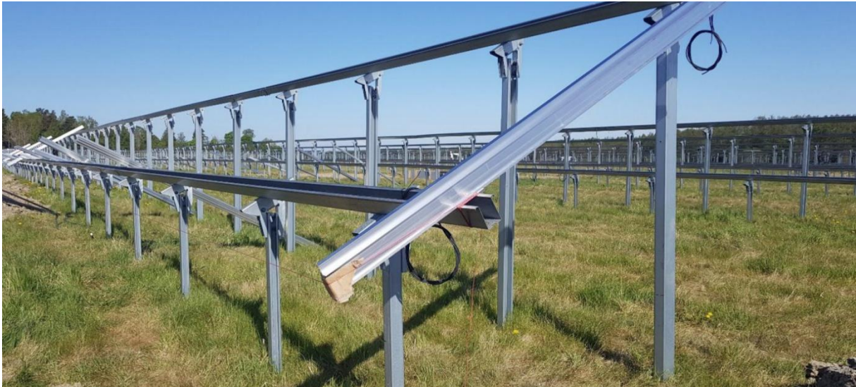
Figur 3 - Panelbord som solcellspanelerna monteras på.
