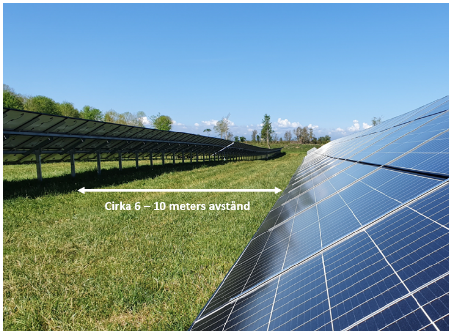
Figur 6. Illustrerar ungefärligt avstånd mellan panelraderna (EnergiEngagemang 2024).
