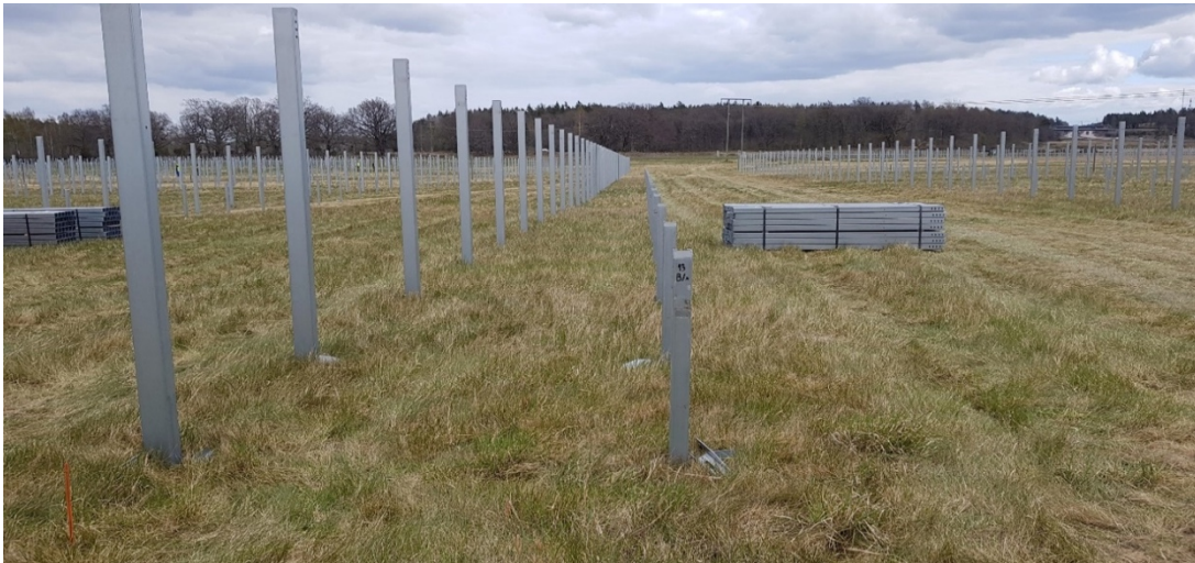
Figur 3. Bild på pålade markstolpar (EnergiEngagemang 2024).
